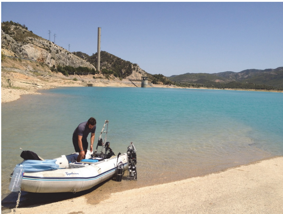
Figura 8. Vista del punto de acceso al embalse
