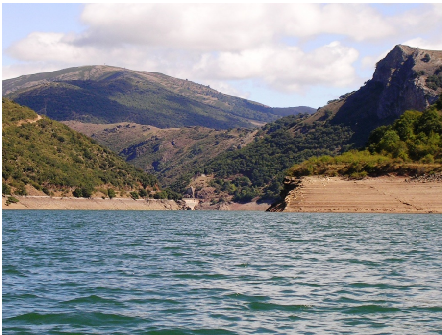
Figura 7. Vista de la presa del embalse.
