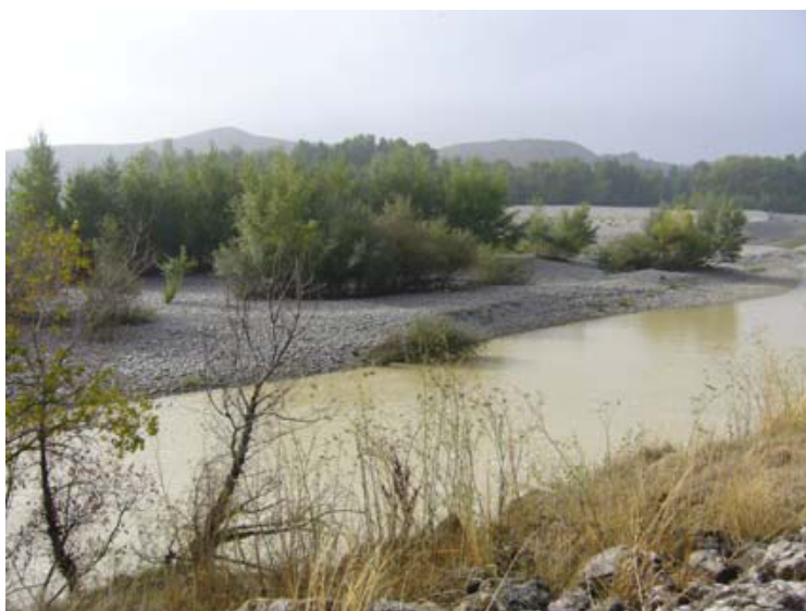
Acumulación de gravas. El río busca nuevo espacio y carga contra la margen derecha en donde se encuentra una escollera que está a punto de derrumbarse
