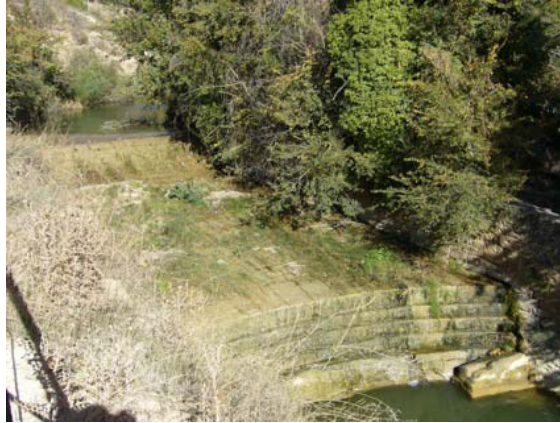
Azud de la Fuente Recarte, aguas arriba de Tafalla. Deriva agua por margen derecha para riegos
