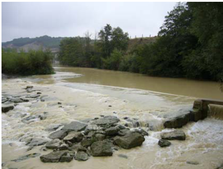
Azud de Marcilla. Deriva agua por la margen izquierda a la comunidad de regantes de Villafranca, Cadreita y Milagro.
