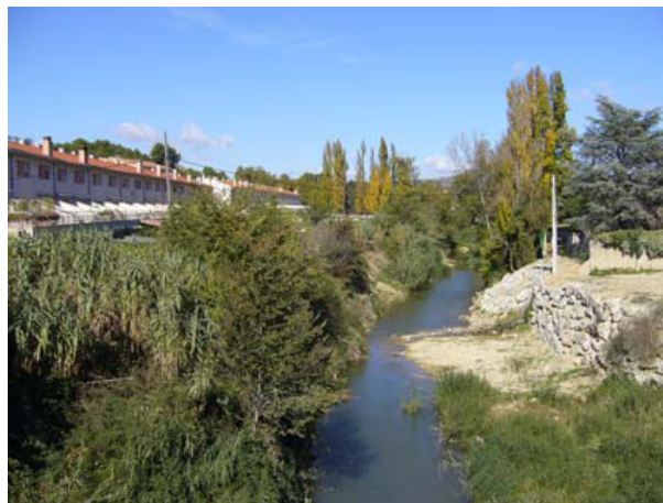
Escolleras de protección a la altura de Tafalla.
