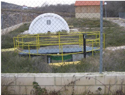
Depuradora de Arija de Abajo.
