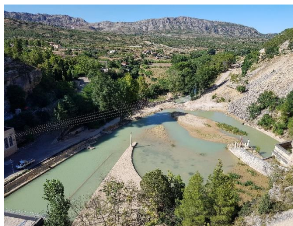
Figura 10. Balsa de decantación. Aguas abajo embalse Santolea. 05/08/2020.
