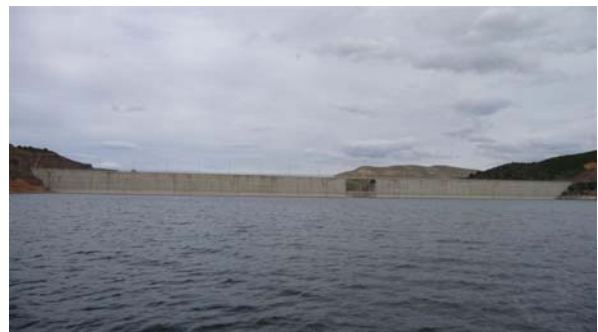
Foto 4: Presa del embalse El Val
