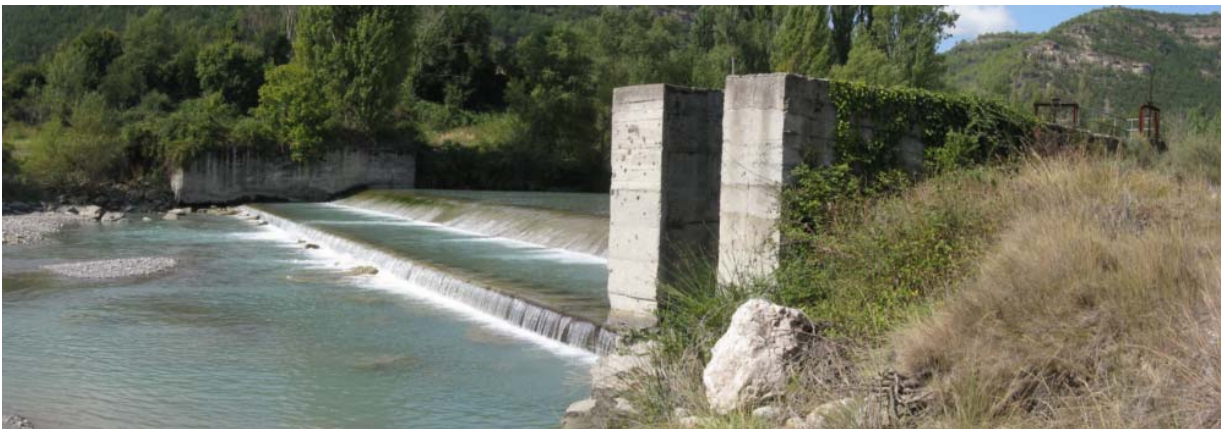
Fig. 4. vista desde la margen izquierda del azud
