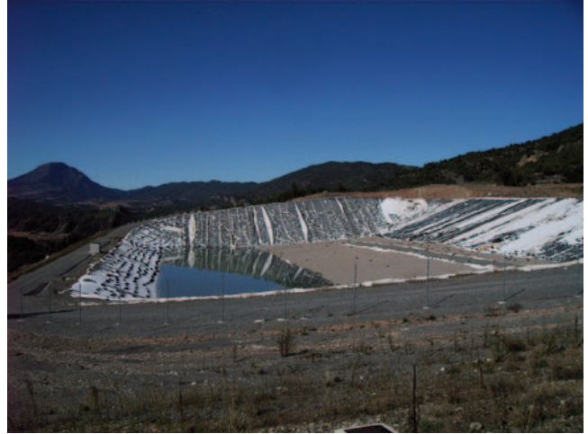
Nuevo vertedero de seguridad Bailín.
