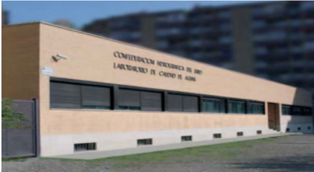
Fachada del Laboratorio de Calidad de Aguas.
