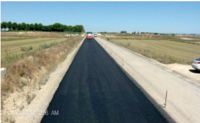
Camino CG-2. Reconversión a carretera nacional.
