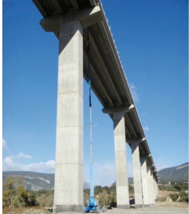
Obras carretera A-1601.
