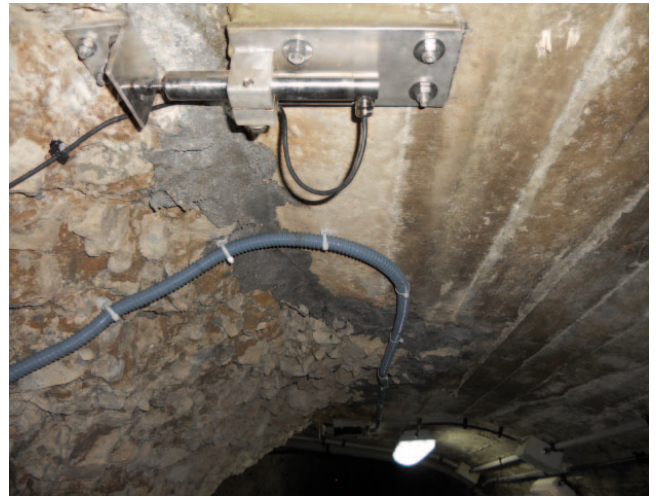
Presa de Mediano: Nuevo medidor de juntas instalado en la presa, sensor tipo LVDT.
