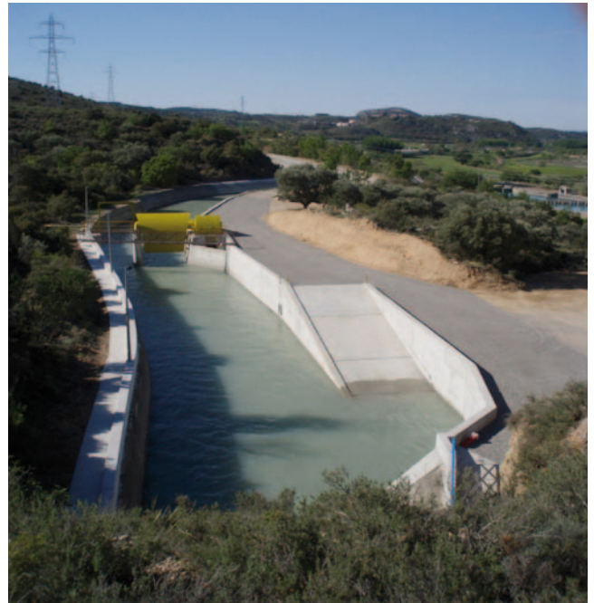
Mejoras en los puntos de regulación del Canal de Aragón y Cataluña.
