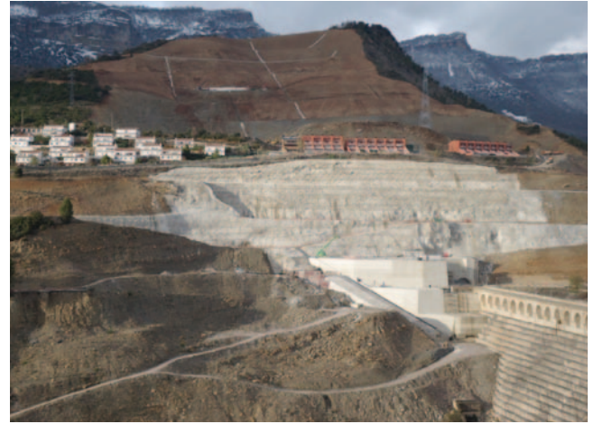
Ladera estribo derecho presa de Yesa.
