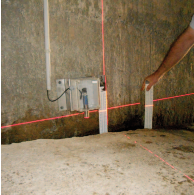
Presa de González Lacasa: Aforador 1 margen derecha. ajuste del mismo mediante láser. se comprueba que coincidan la escala manual y el vértice del vertedero.
