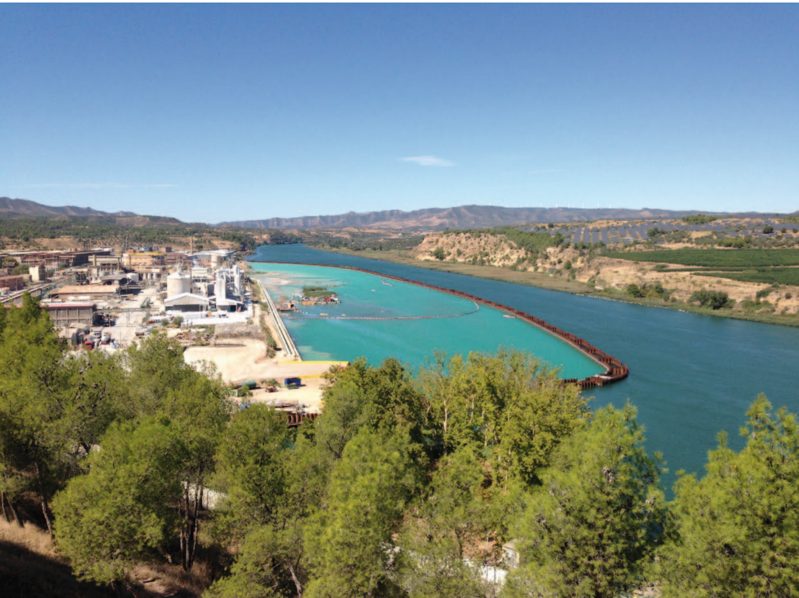
Estado de las obras de descontaminación del embalse de Flix.
