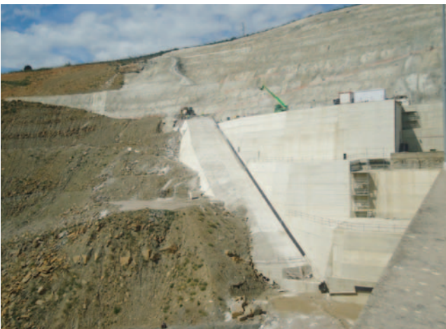
Ladera estribo derecho presa de Yesa.
