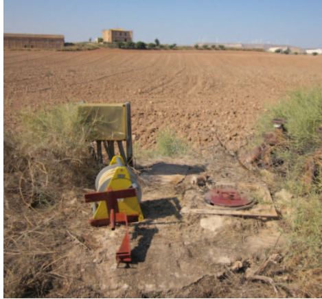
Adecuación realizada para su protección y para facilitar la medición.
