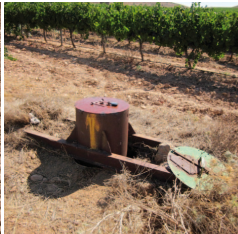
Adecuación realizada para su protección y para facilitar la medición.
