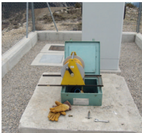
Vista general de su aplicación en campo.
