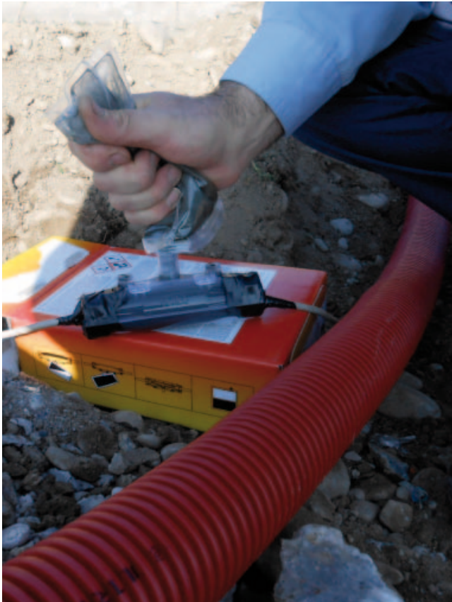
Presa de Sotenera: Recuperación de piezómetro de cuerda vibrante que había resultado dañado en trabajos en la bermá de la presa.
