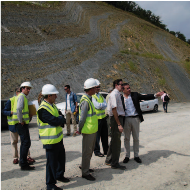
Visita obras estabilización ladera derecha del embalse de Yesa.
