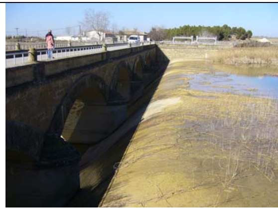
Cruce del Canal de Bardenas con el río Arba de Riguel
