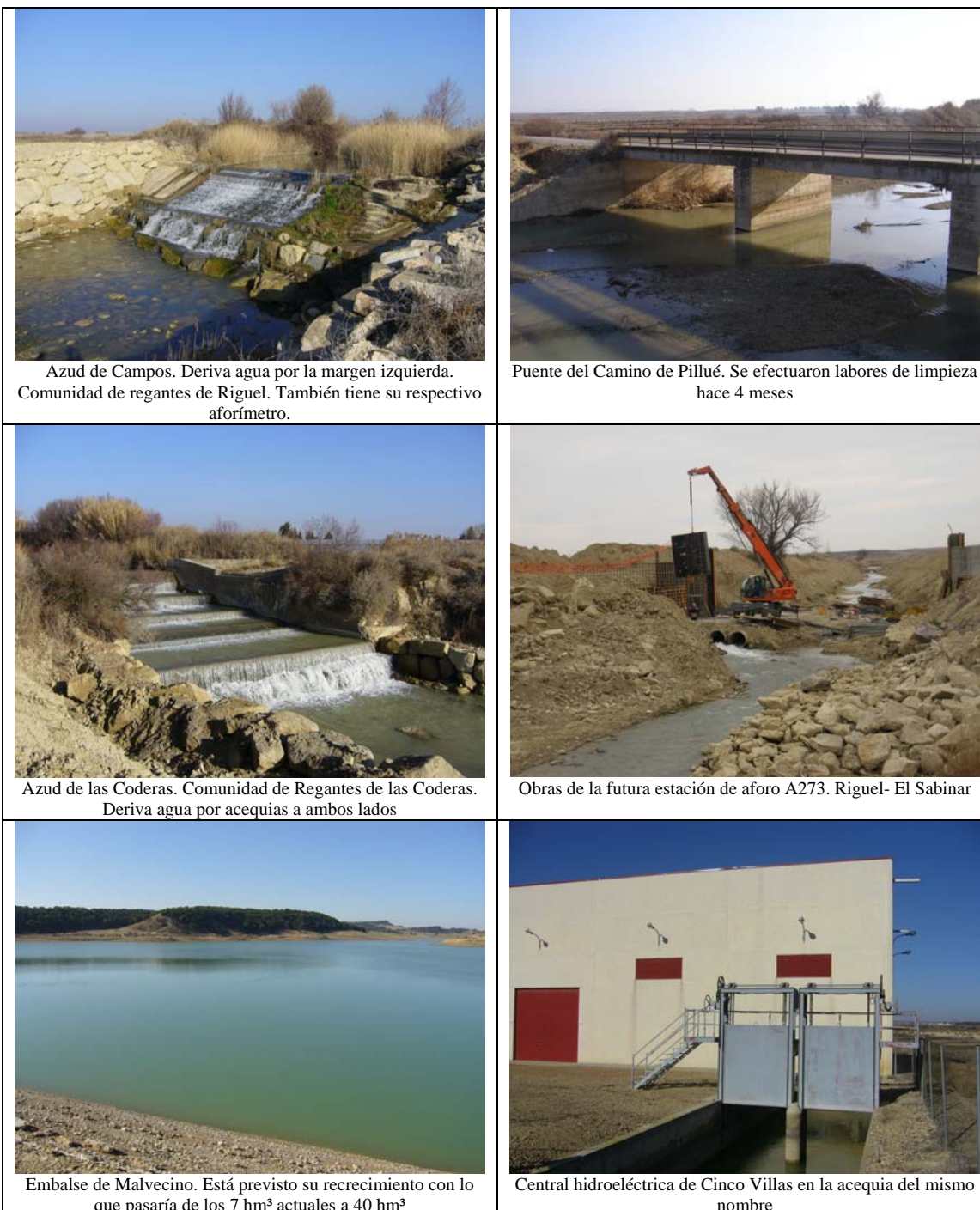
Figura 3.5. continuación. Fotografías representativas de algunas de las presiones y características de la masa 105. Fotografías realizadas el 7/02/2008.
