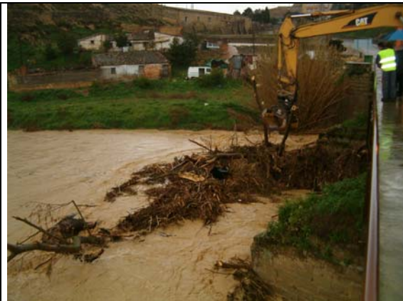
Máquina trabajando para eliminar los arrastres acumulados en el puente (Ejea, abril de 2007)
