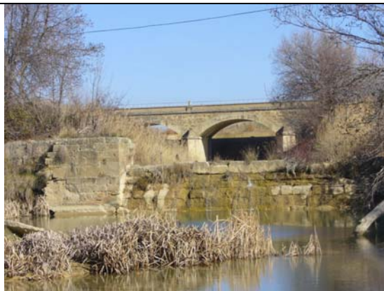
Azud de Santa María. Este azud es el primero que recibe aguas del canal de Bardenas. Al fondo puente de la carretera de mantenimiento del Canal de Bardenas y cruce del mismo con el río Arba de Riguel.
