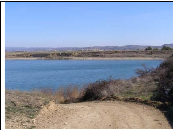
Embalse de Valdefafuen para la regulación interna del sistema Bardenas. Al fondo núcleo de Layana
