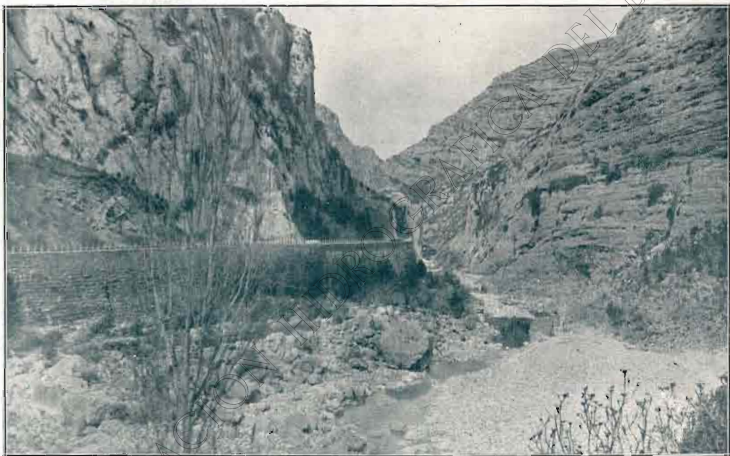
ENSANCHAMIENTO DEL CAUCE DE ESERA, LLAMADO DE "AGUA SALADA", A LA SALIDA DEL ESTRECHO DE LAS PALOMAS. A LA IZQUIERDA, EL CANAL DE ARAGÓN Y CATALUÑA
