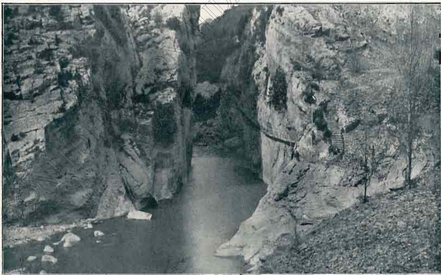
EMPLAZAMIENTO DE LA PRESA DE CONTRAEMBALSE CONGOSTO DE LAS PALOMAS, VISTO DESDE AGUA ABAJO
