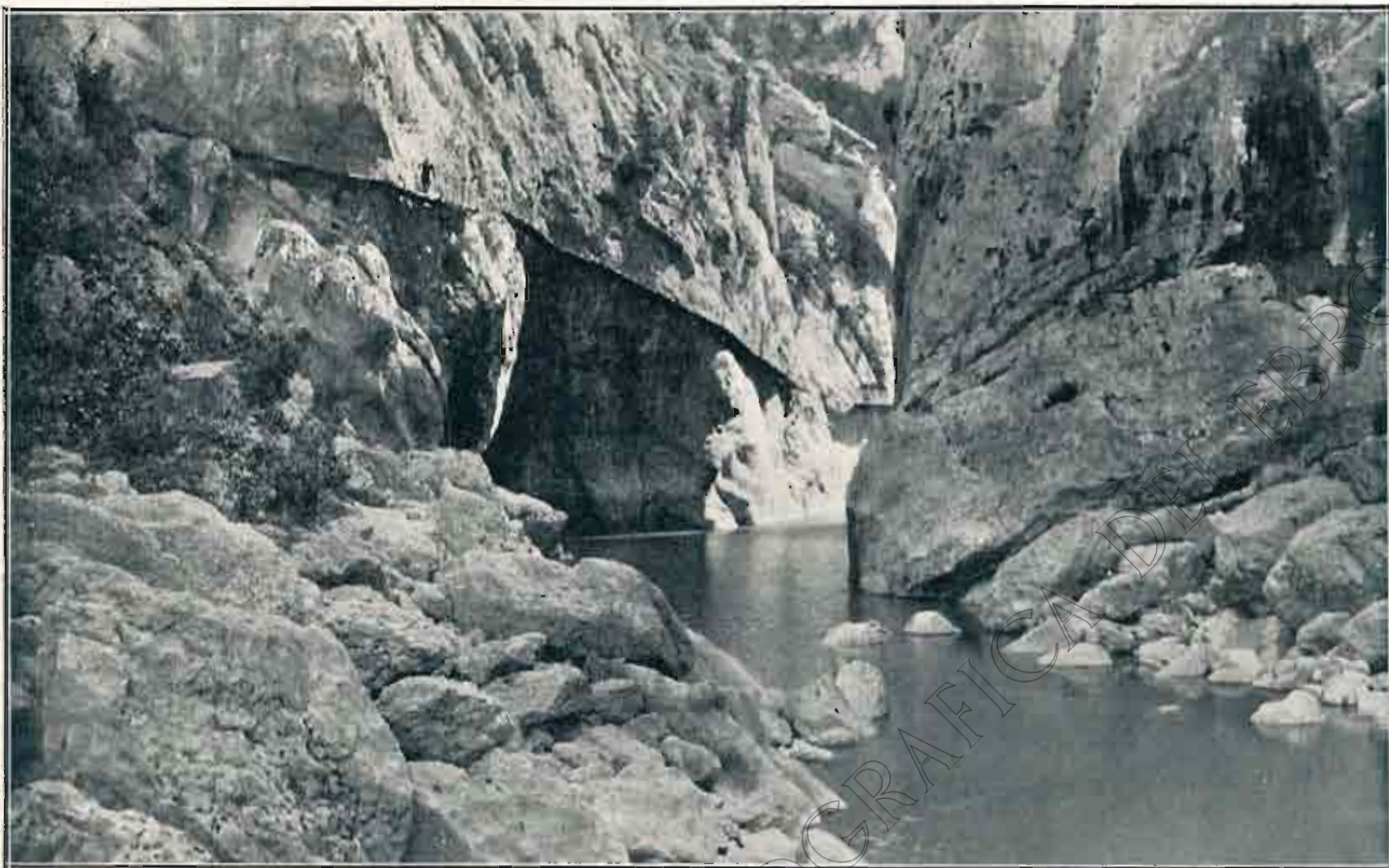
EMPLAZAMIENTO DE LA PRESA DE CONTRAEMBALSE CONGOSTO DE LAS PALOMAS, VISTO DESDE AGUA ARRIBA
