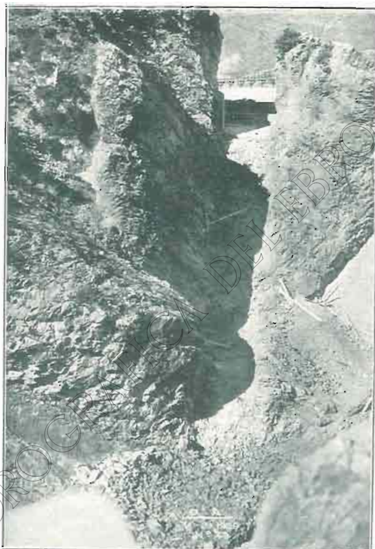
Aliviadero y pasarela sobre la presa, en el de Febrero de 1929.
