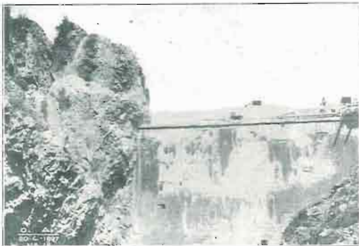
Estado de las obras de recrecimiento de la presa en 20 de Abril de 1927.
