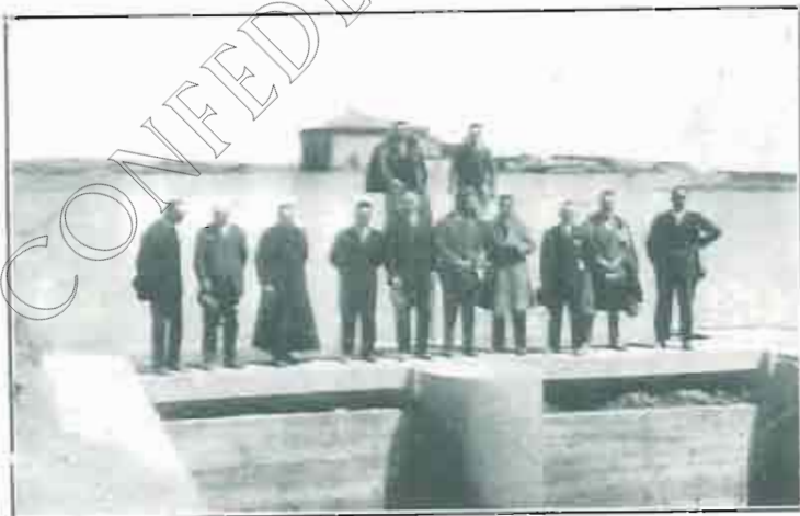
La Junta Social en la obra de paso del barranco de la Yosa (Aldanueva de Ebro)
