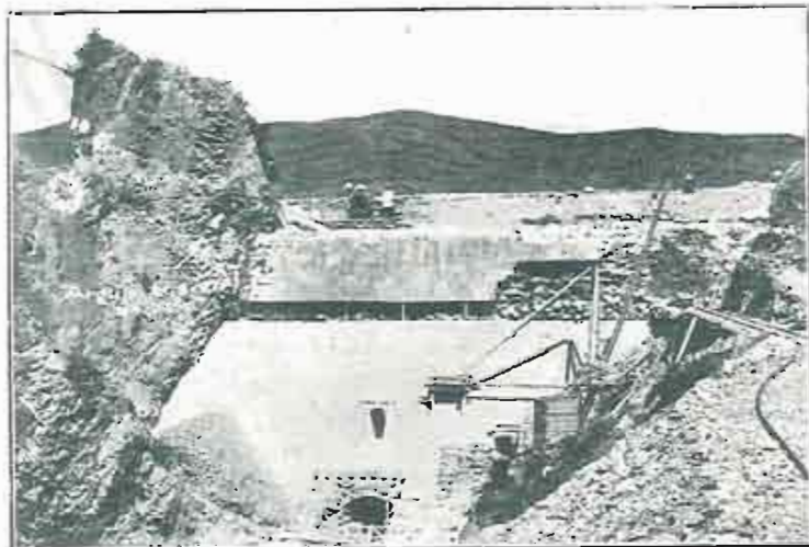
Estado de las obras de recrecimiento de la presa en 21 Septiembre de 1927.
