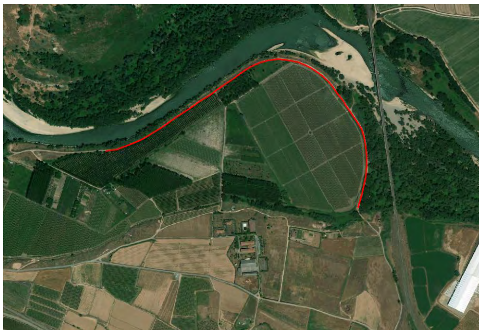
Imagen 13: Tramo de mota a demoler en la zona 4
