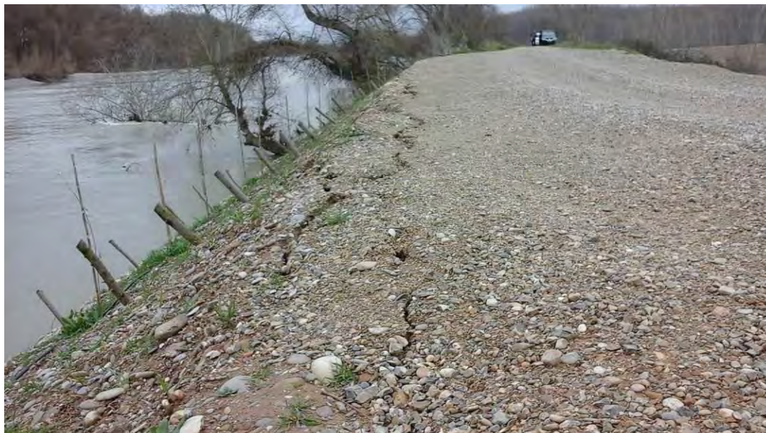
Imagen 9: Imagen de mota a demoler en la zona 2
