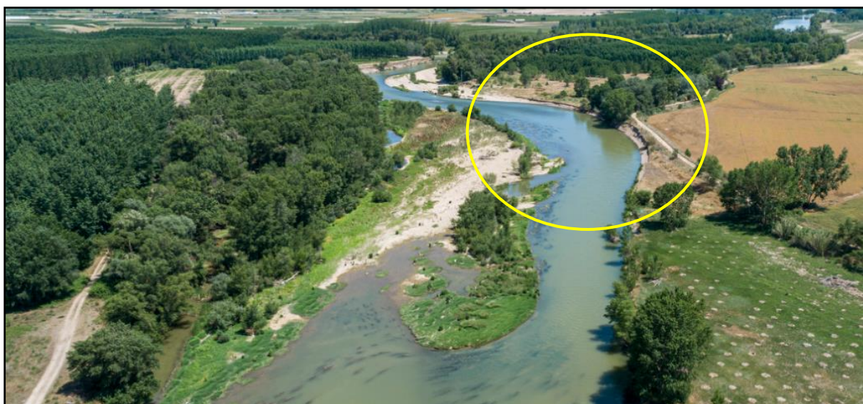
Figura 7. Estado de las erosiones en la orilla derecha (previo a la fase1). Fotografía CHE 2020.
