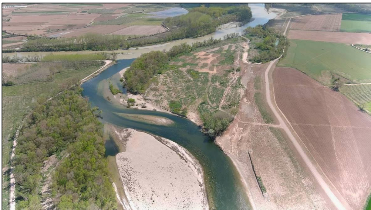
Figura 4. Estado final de las actuaciones Ortigoso Fase 1, Milagro (Navarra). Fotografía CHE 2024.
