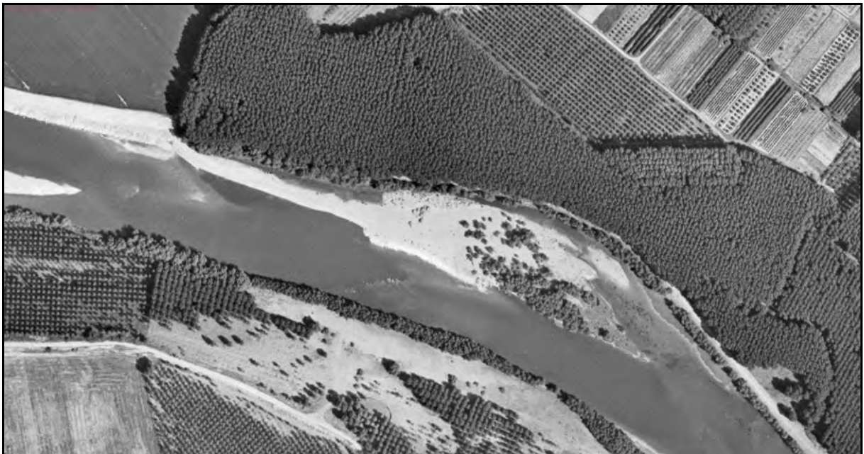
Figura 15. Isla y construcción de defensas en 1997 (IDENA).
