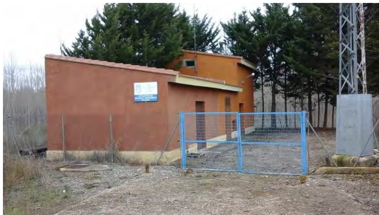
Imagen 10: Instalación de los pozos de extracción
