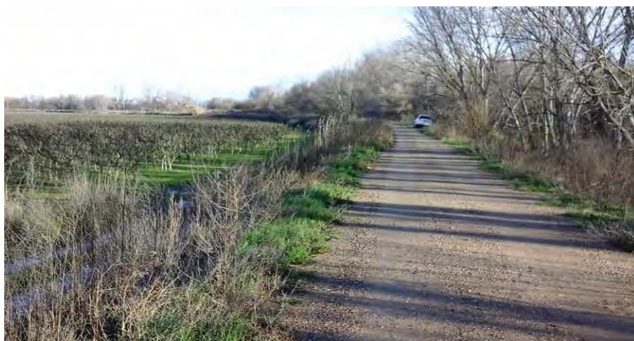
Imagen 12: Mota a demoler zona 4
