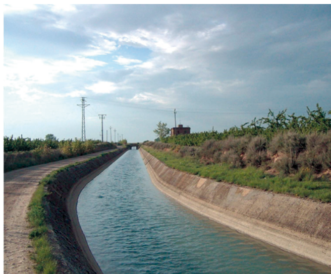
Acequia de Esplús (Canal de Aragón y Cataluña)
