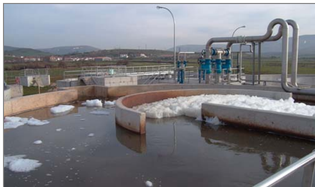
Depuradora de aguas residuales de Reinoso (Cantabria)
