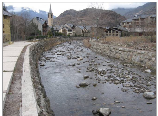
Encauzamiento del río Noguera-Pallaresa en Esterrí d'Aneu
