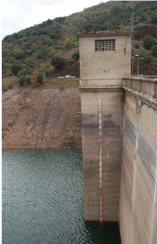
Detalle de la presa. Primavera de 2005 (31/03/2005)
