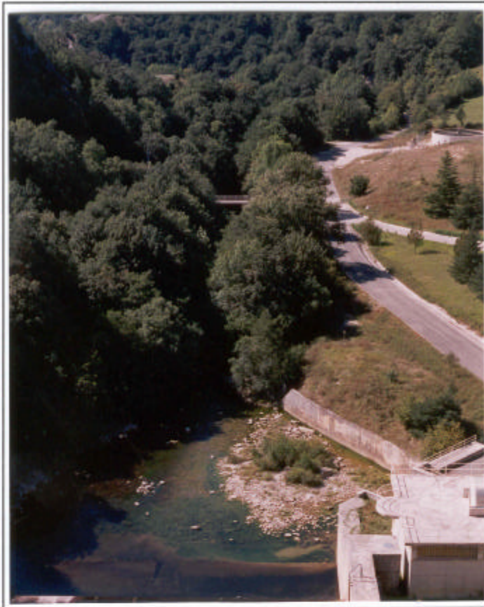
Colchón y tramo fluvial aguas abajo de la presa de Eugui.
